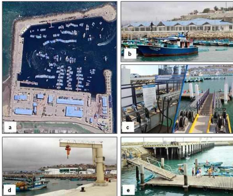
Figura 7. Puerto pesquero artesanal de Jaramijó<sup>6</sup>; a) vista superior; b) vista frontal; c) estación de combustible; d) área de desembarque (embarcaciones de hasta 30 ton); e) área de desembarque de embarcaciones artesanales.
